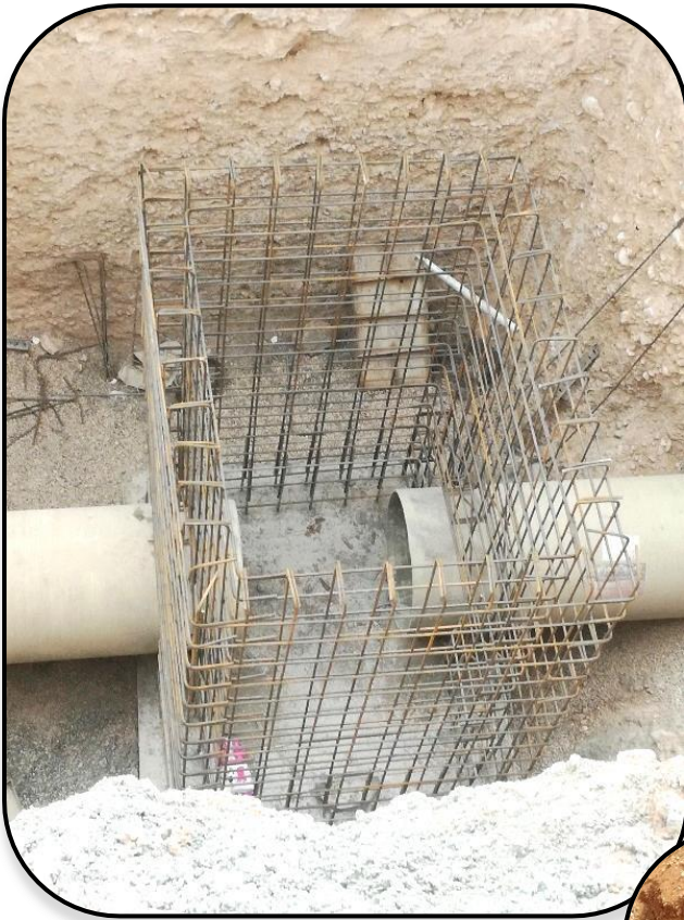
آرماتوربندی منهول بتن درجا
