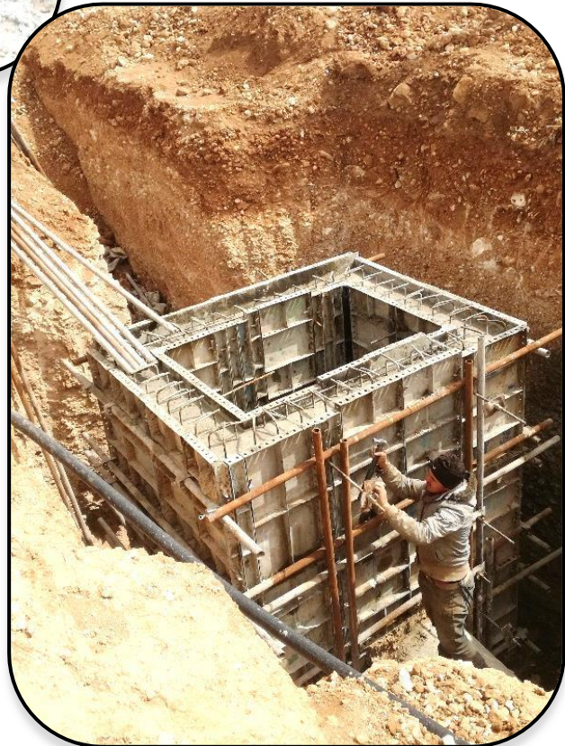
قالب‌بندی و بتن‌ریزی منهول بتن درجا
